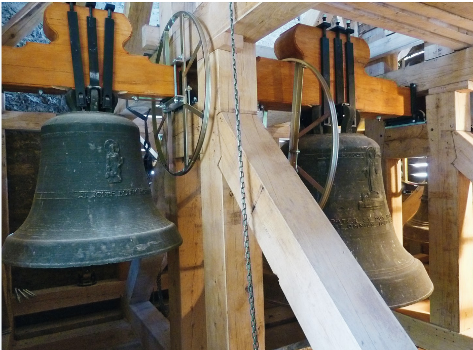
Ein Blick auf den neuen hölzernen Glockenstuhl der Abteikirche Münsterschwarzach offenbart Holz-Holz-Verbindungen, wie man sie sonst nur noch in alten Lehrbüchern findet.
