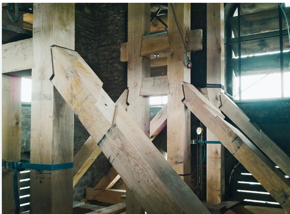
Die Endmontage war unter Last durchzuführen, und so wurde zunächst provisorisch gerichtet, dann wurden die Glocken eingehängt und schließlich die Schrauben und Dübel gebohrt und eingebaut.
