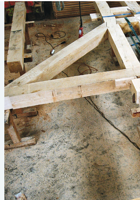
Während der Arbeiten in der Abbundhalle legten provisorisch zusammen, um die geforderten
